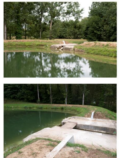
Les travaux du Carpe sont terminés
